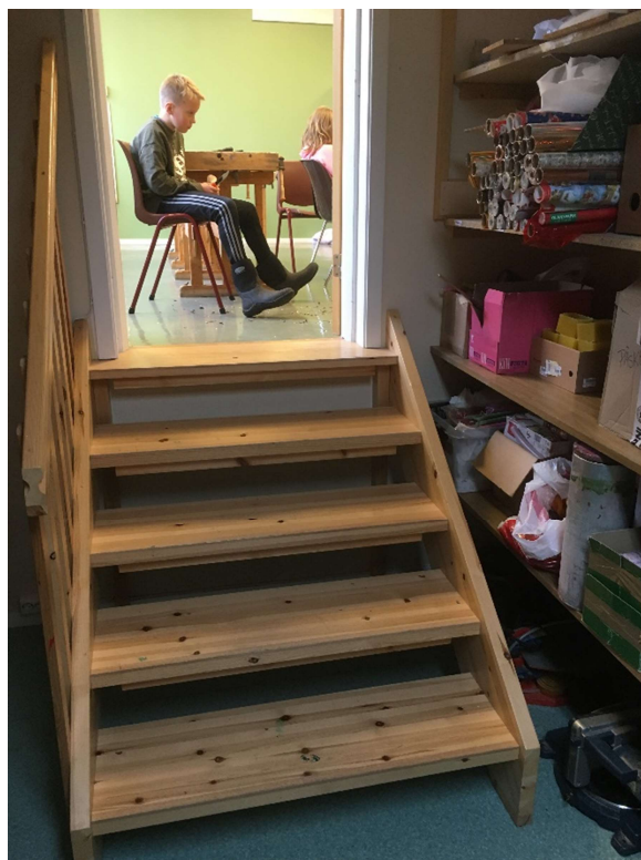
Figur 2.2.1-4 – Trapp sløyd til lagerrom
