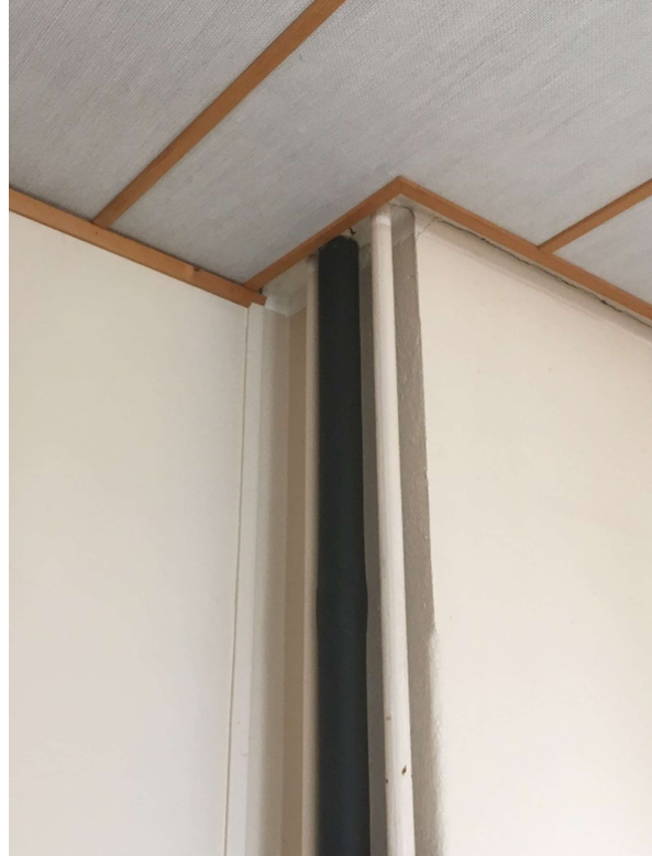
Figur 2.1.2.2– 12 Rør i 1. etasje klasserom
