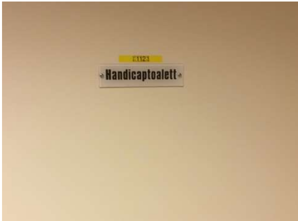
Figur 2.3.1-7 – Mangler taktile merke
