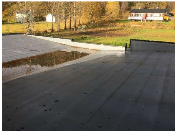
Figur 2.2.1-12 – Flattak med folietekking
