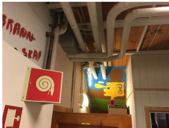
Figur 2.1.2.2– 8 Rør I underetasje korridor
