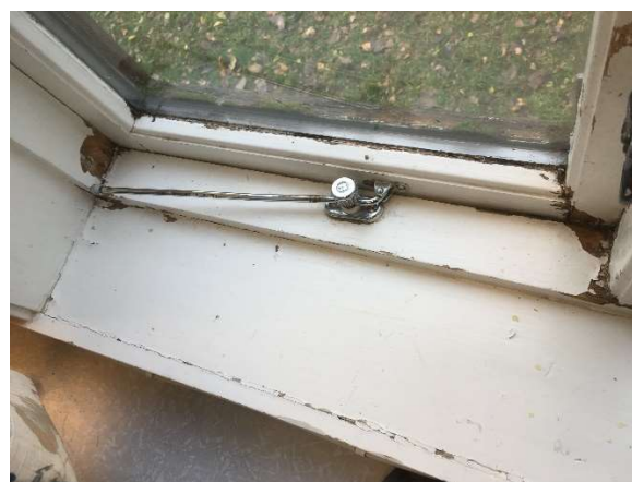
Figur 2.2.1-6 – Vindu i skolekjøkken
