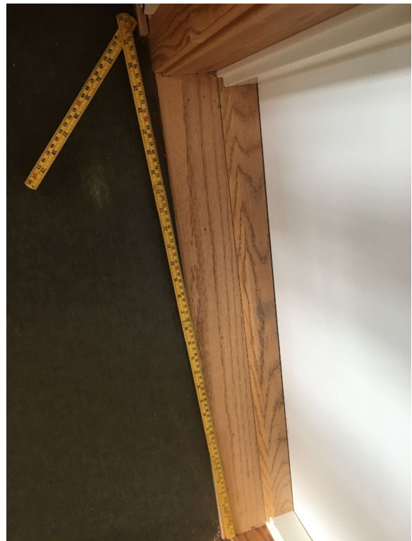
Figur 2.1.1-18 – Dør til rømningstrapp 71 cm breidd
