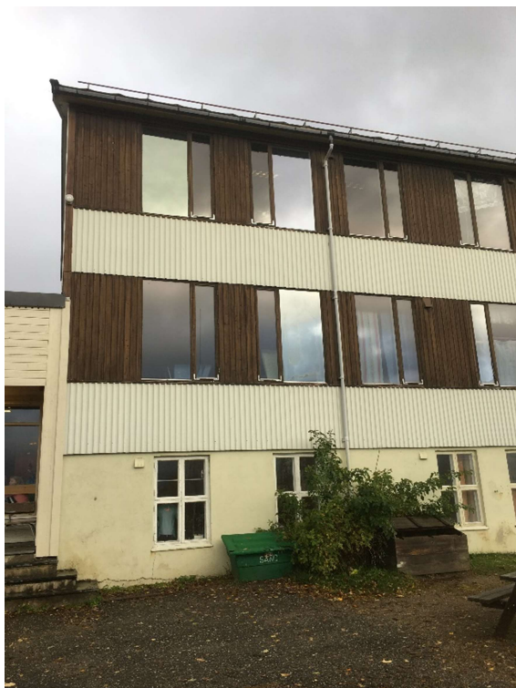
Figur 2.1.1-1 – Uisolert underetasje
