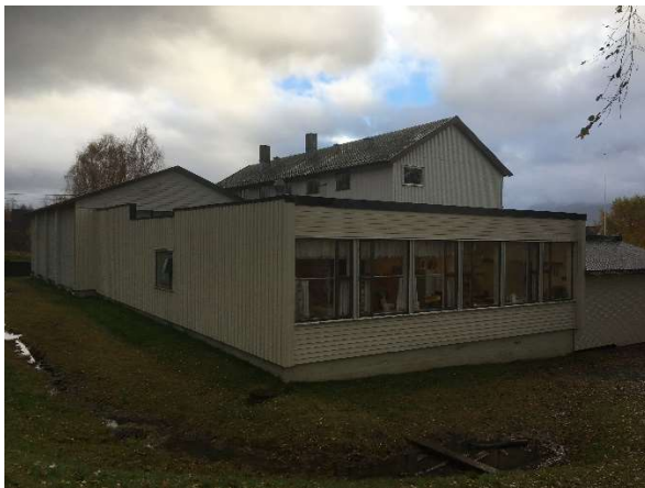
Figur 2.2.1-11 – Bygning i 1 etasje
