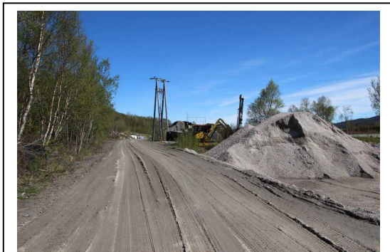
Figur 9: Fra steinbruddet mot kryss Fv. 835.
