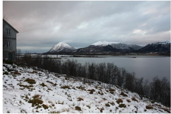
Engeløybrua sett fra enden av veggen på Jensvikhågen
